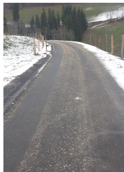
Erster Bauabschnitt Zosner-Straße Asphaltierung bis zur Weggabelung
